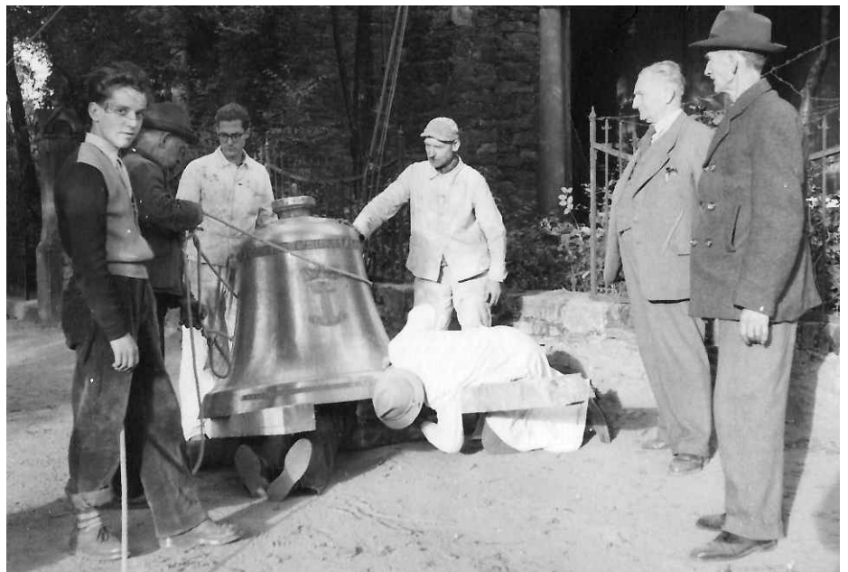
Am 5. Oktober 1955 halfen die Gemeindemitglieder Karl Speth jun. (rechts der mittelgroßen Glocke auf dem Boden liegend), Wilhelm Speth (3. von links) und Karl Speth sen. (rechts) bei den notwendigen Vorarbeiten, um das Geläut unverzüglich installieren zu können.
