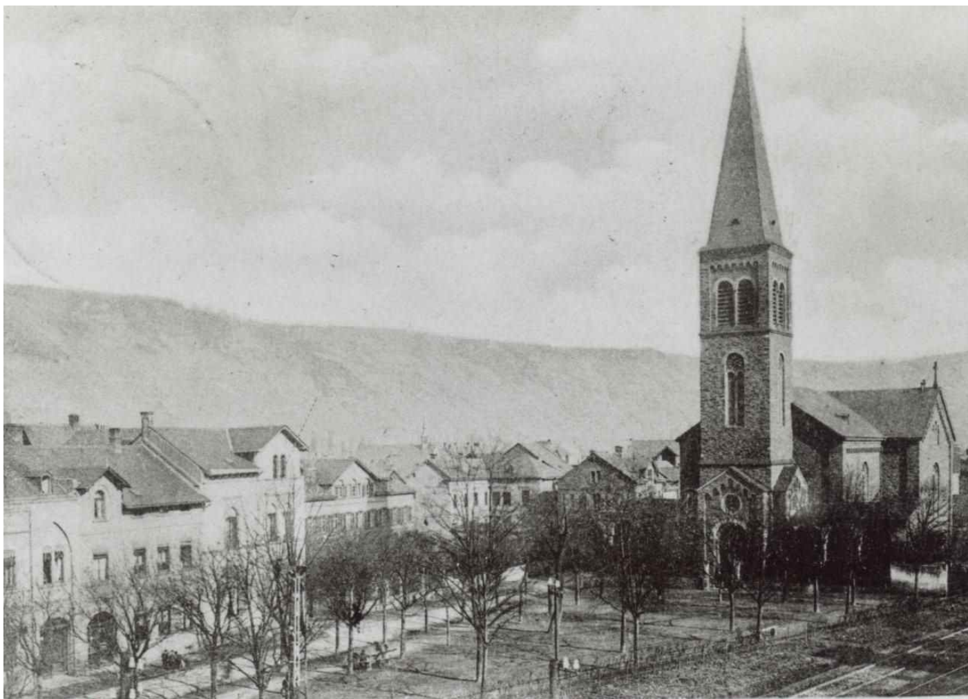
Der Erweiterungsbau der Christuskirche bot von Südwesten aus mit dem ihm vorgelagerten Angert um das Jahr 1900 diesen Anblick.
