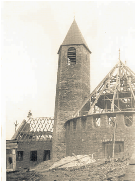
Die neue Kirche von Herkersdorf im Rohbau. Die Grundsteinlegung erfolgte am 12. Mai 1957.
