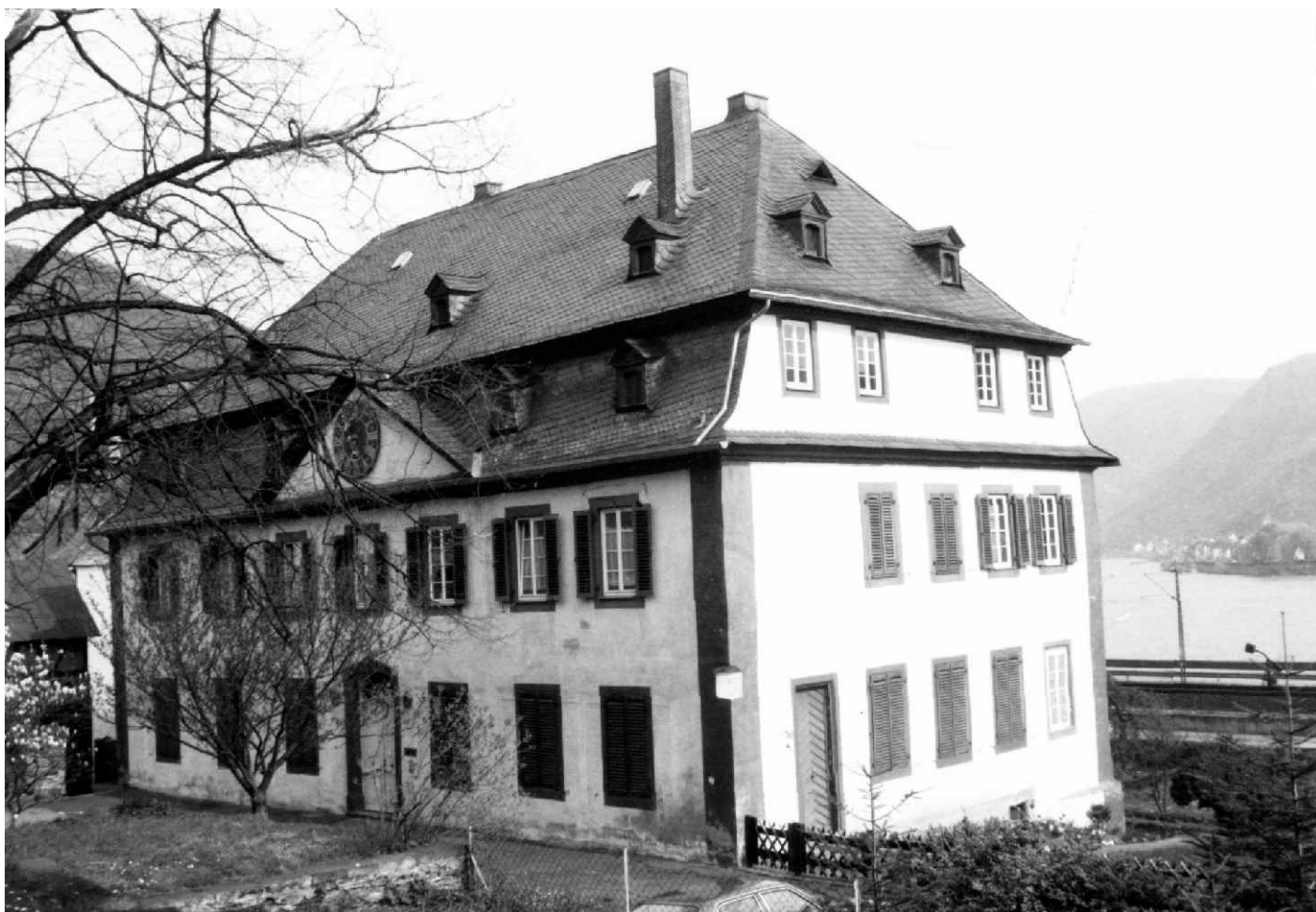
Pfarrhaus (ehemaliges Propsteigebäude) von Südwesten, April 1988.
