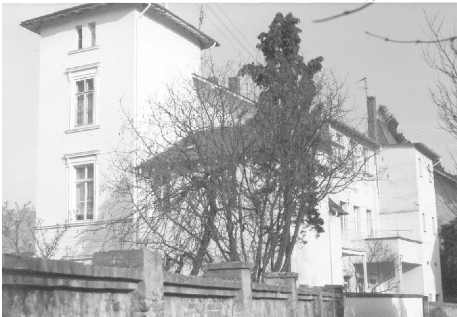
Das Haus in der Mainzer Straße 51, Ansicht vom Blutgässchen.
